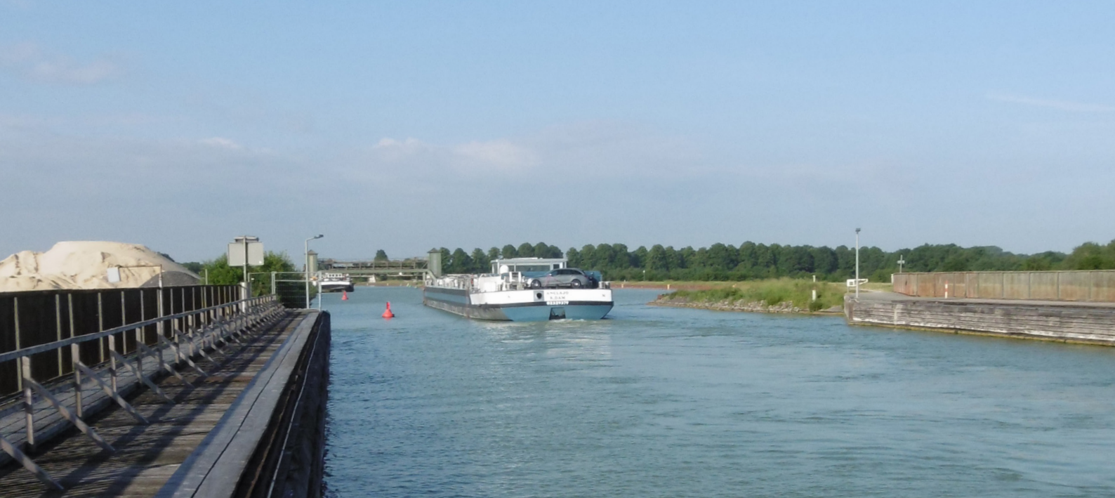
Dortmund-Ems-Kanal, Blickrichtung Süden
