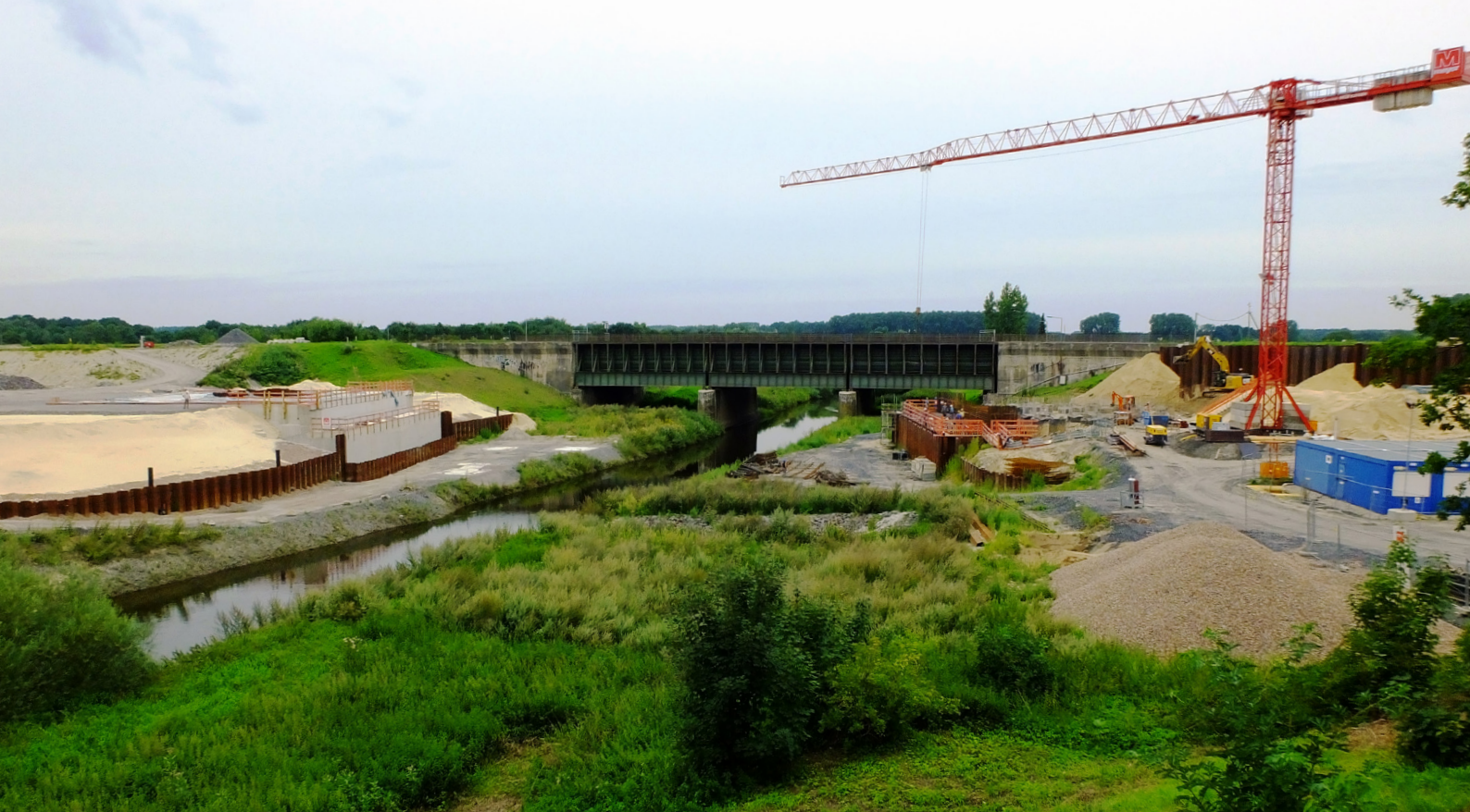
Blick auf die Kanalbrücke Ems
