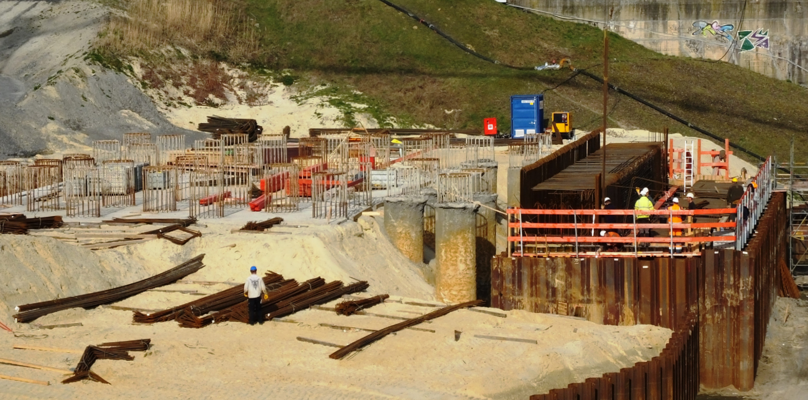
Ansicht südliches Brückenwiderlager
