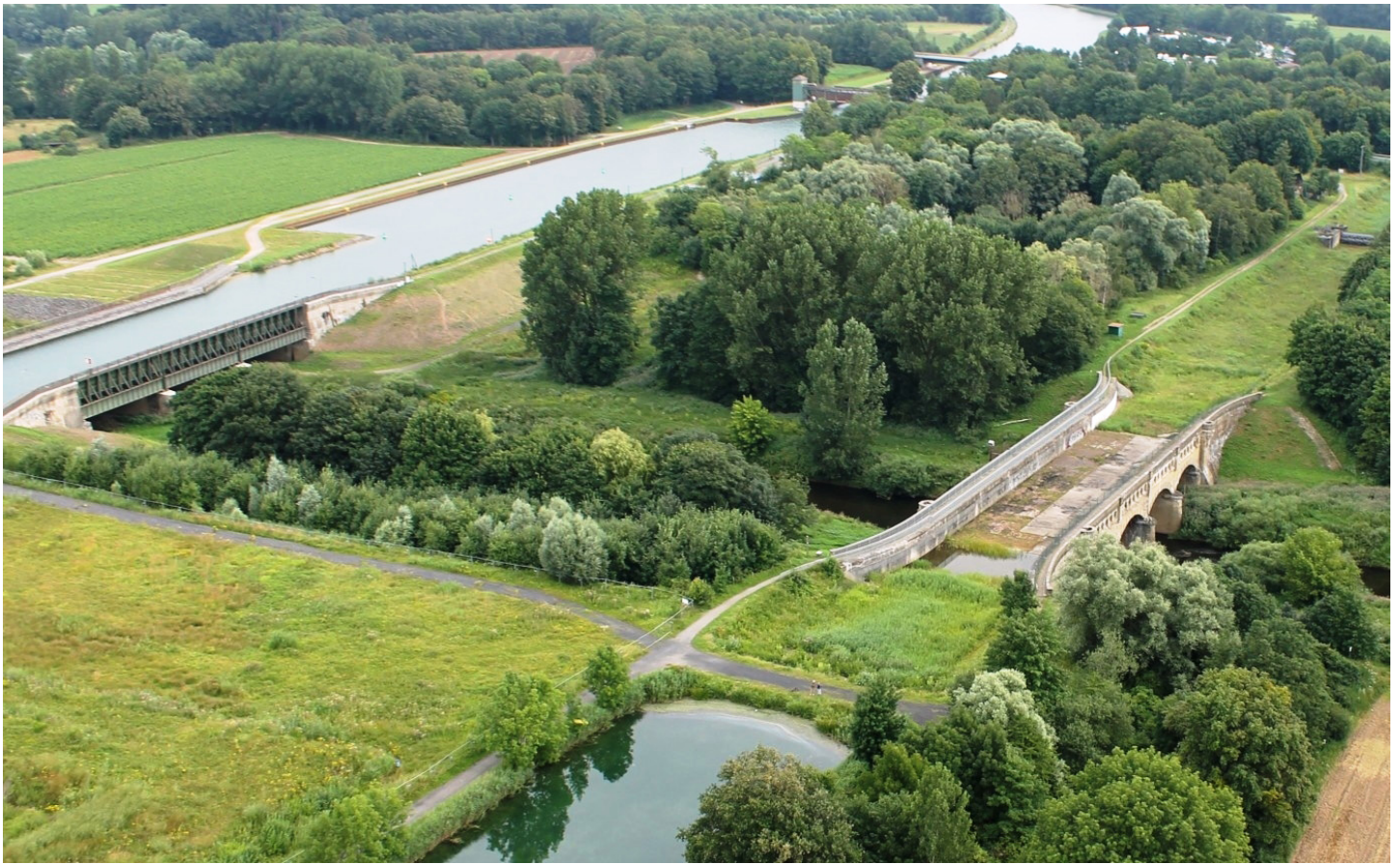
Kanalbrücken Ems - Neue und Alte Fahrt
