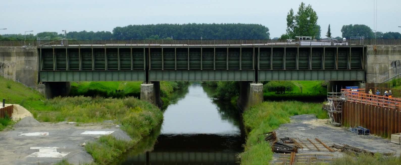
Derzeitige Kanalbrücke - erbaut 1935/36
