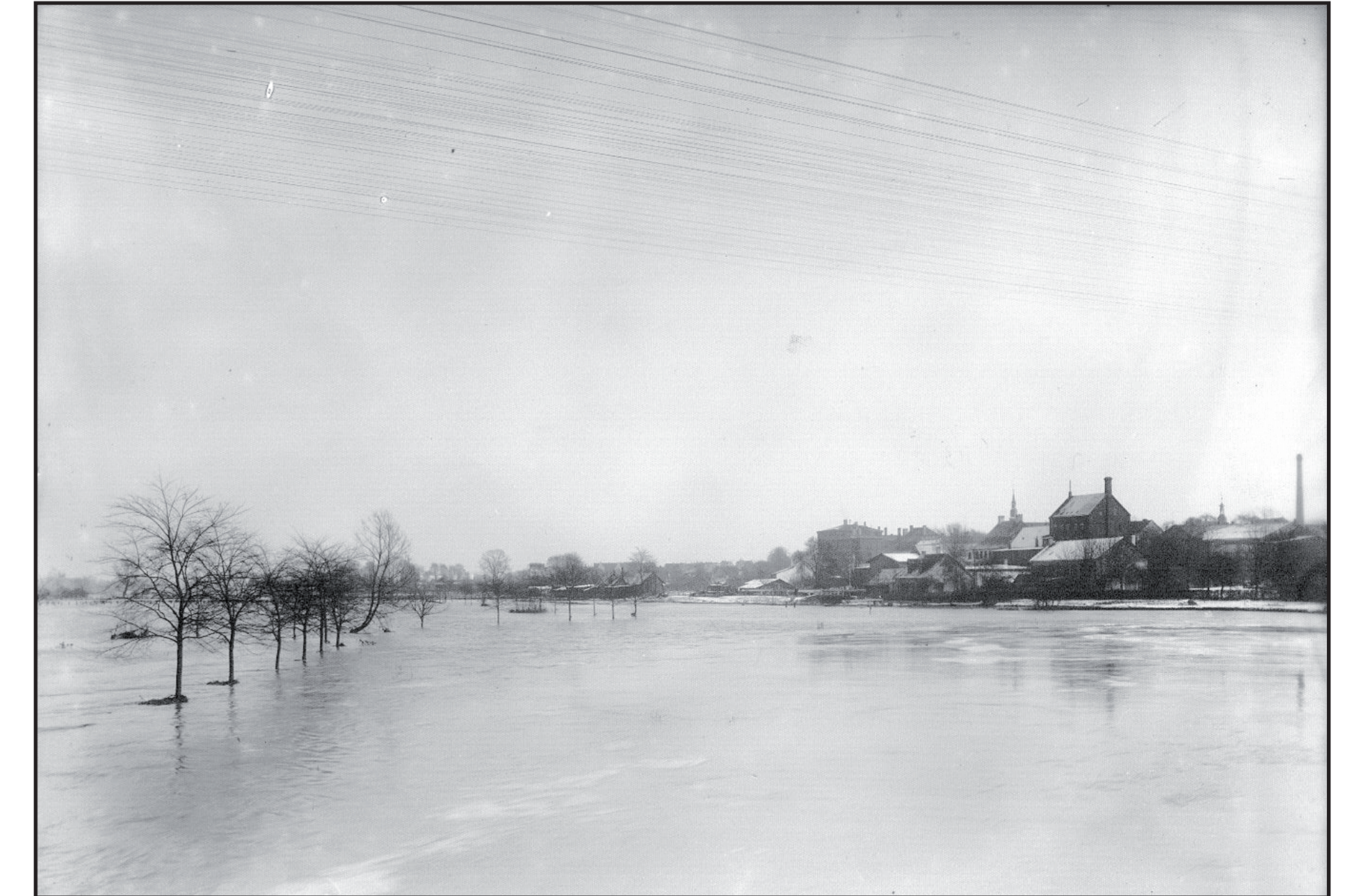
Blick von der Münsterstraßenbrücke nach Hamm - Osten bei Hochwasser am 07. Februar 1909
