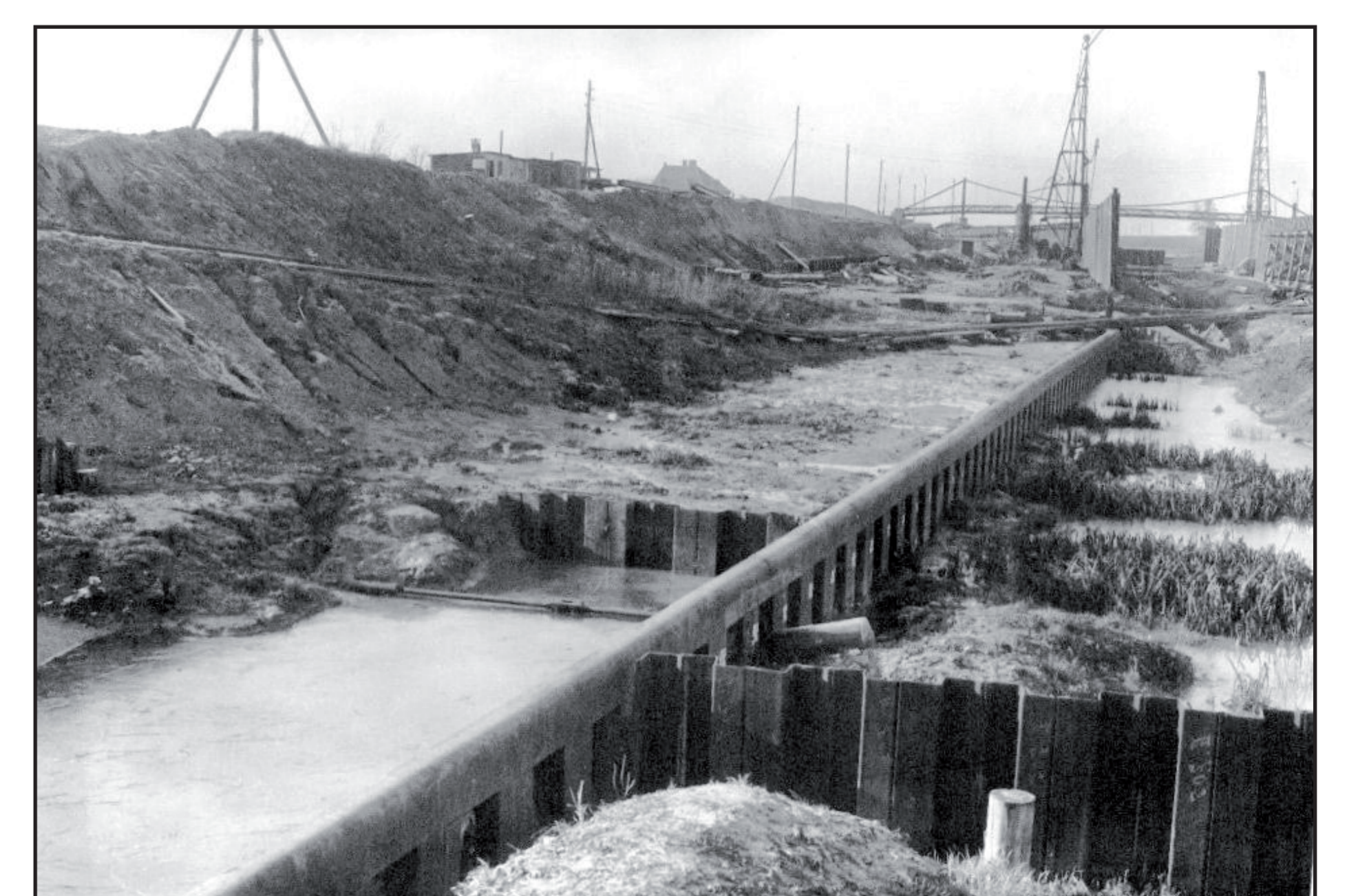
1930 begann der Bau der Schleuse Werries und endete mit der Eröffnung des 2. Teilstückes bis nach Schmehausen am 23. August 1933
