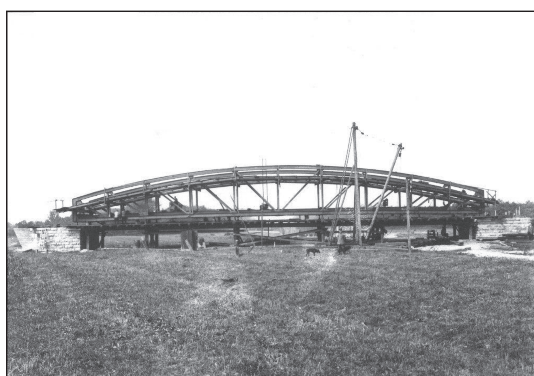
Montage der Eickhoffbrücke Aufnahme vom 23. August 1915
