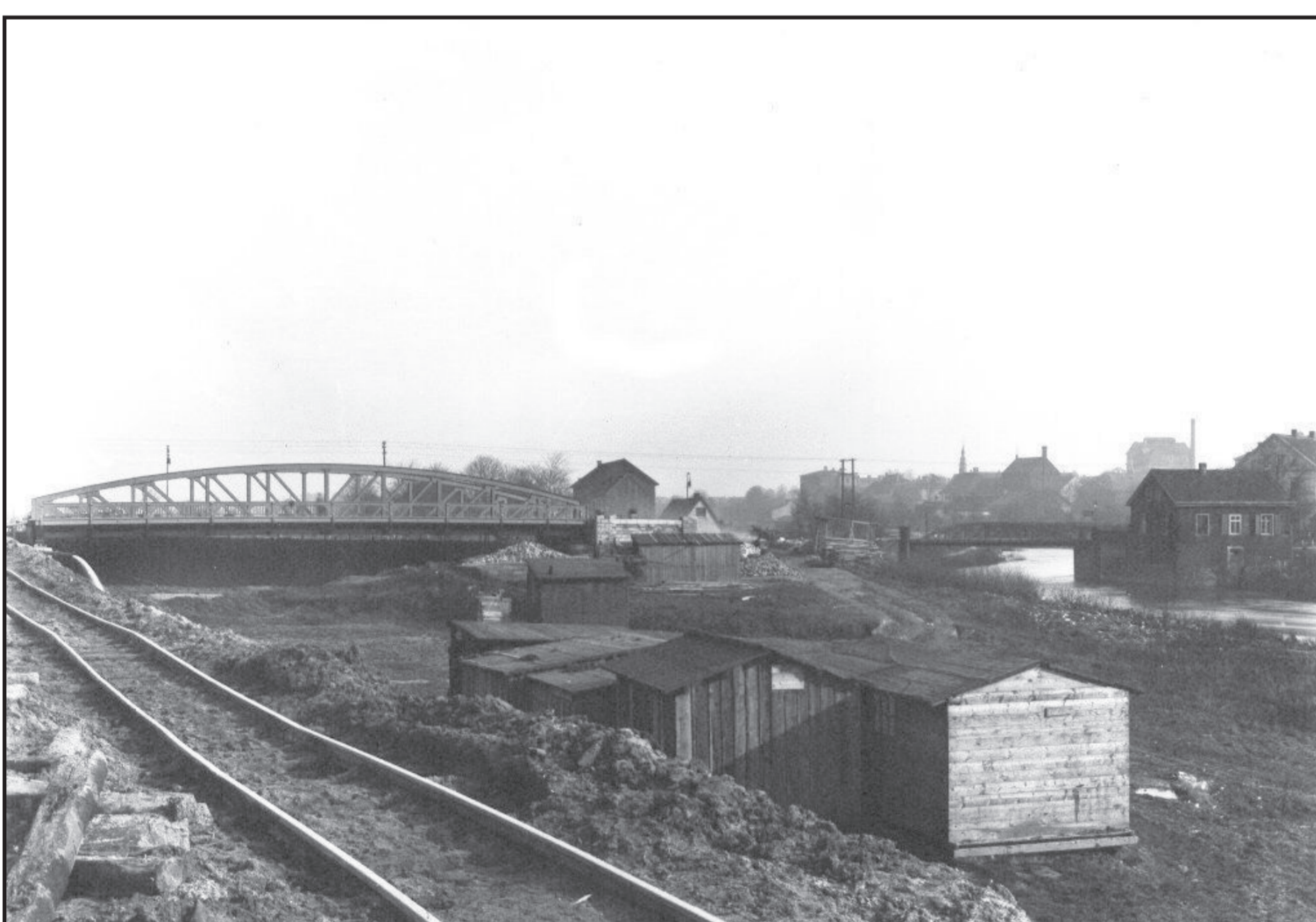
Neue und alte Münsterstraßenbrücke von Westen aus gesehen am 07. November 1912
