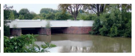
Aufgrund des Bauwerksalters und des baulichen Zustandes kann der bestehende Ahsefluss-Düker die Abflussmengen der Ahse nicht mehr zweifelsfrei abführen.
