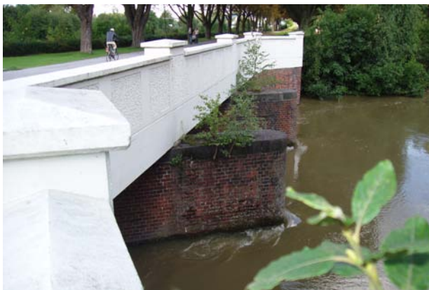
Einlaufbauwerk des Dükers im August 2007
