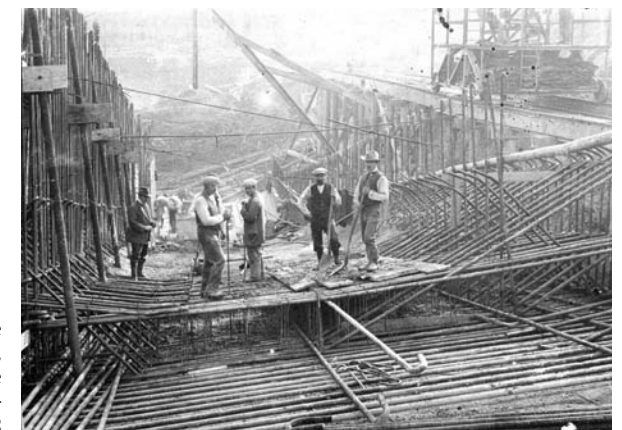
Eiseneinlage im Detail, Aufnahme vom 14. Oktober 1912
