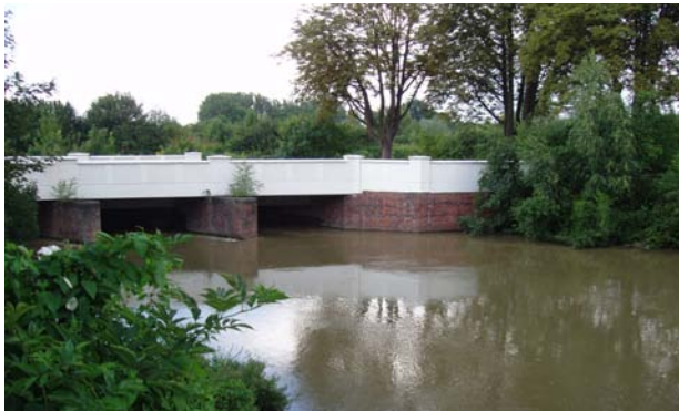
Blick auf das Einlaufbauwerk des Ahsefluss-Dükers im September 2006
