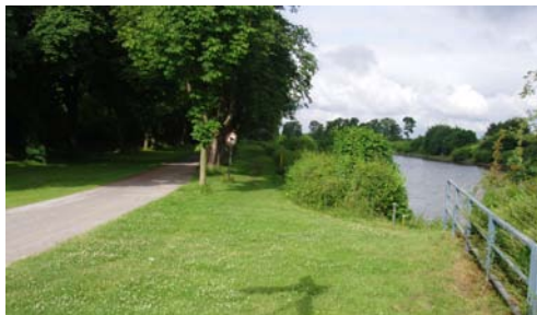
Adenauerallee im Bereich des bestehenden Dükers im Juni 2008
